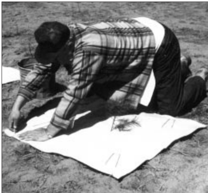
Le produit Terra Mat md est un paillis consolidé fabriqué avec de longs fils de tissu comprimé dans un tapis.
