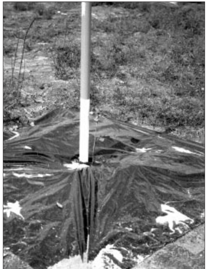
La feuille Brush Blanket MD empêche les herbes de germer en bloquant les rayons du soleil.
