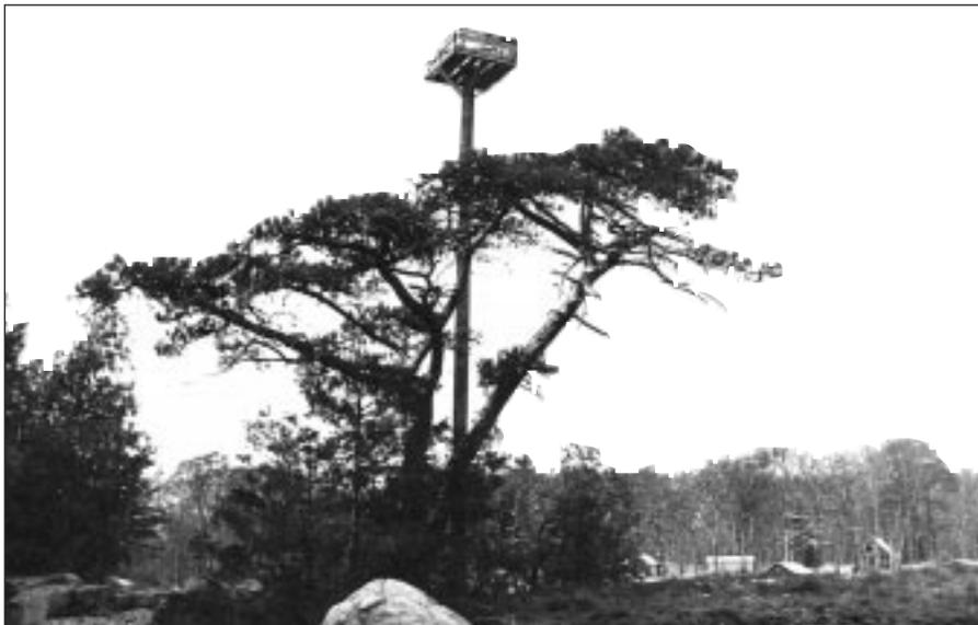
La plate-forme à un poteau est conçue pour une utilisation terrestre. Elle peut être érigée dans des sols profonds ou sur la roche.
